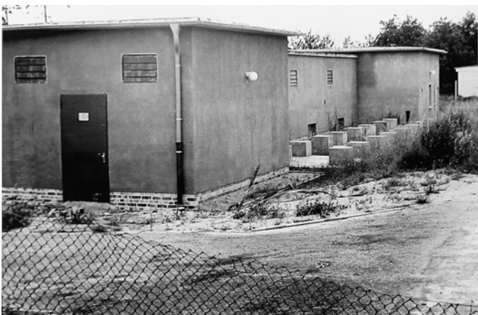
Wasserwerk Techentin ca. 1974
